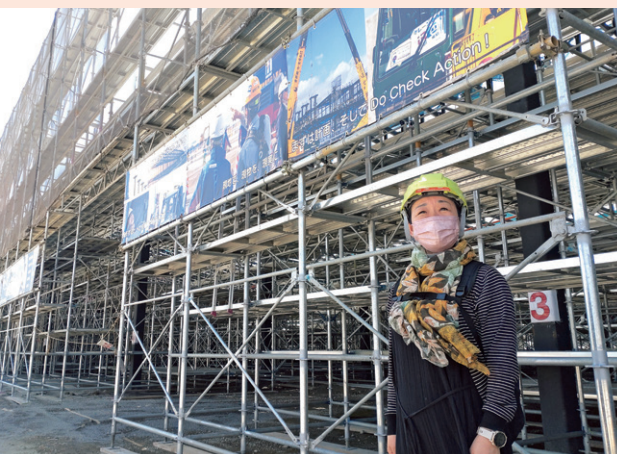
② 工事中西ゲート
